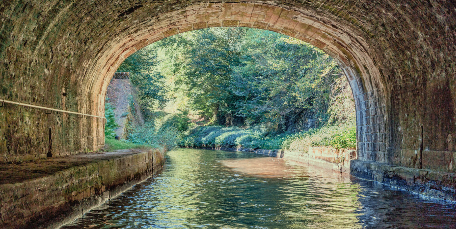
Les Voûtes de la Collencelle (© Lezbroz )
